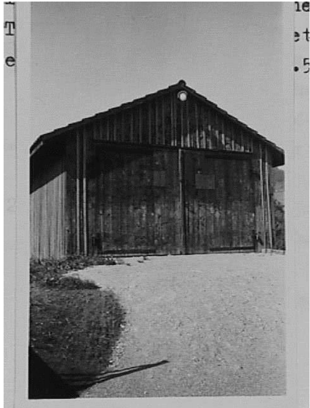
Die Turngeräte-Baracke von 1959
