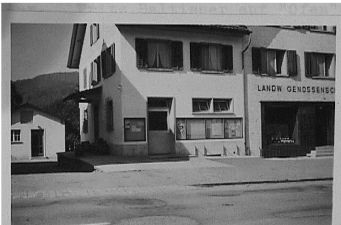
Das umgebaute Milchlokal im südlichen Teil des VOLG-Gebäudes mit den neuen beleuchteten Anschlagkästen. Links hinten das ehemalige Gemeinschaftskühlhaus (heute eine private Garage)
