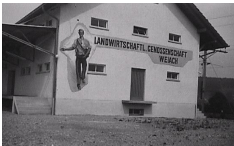
Abb. 23: Lagerhaus der Landwirtschaftlichen Genossenschaft an der Kaiserstuhlerstrasse 44, erstellt 1957
