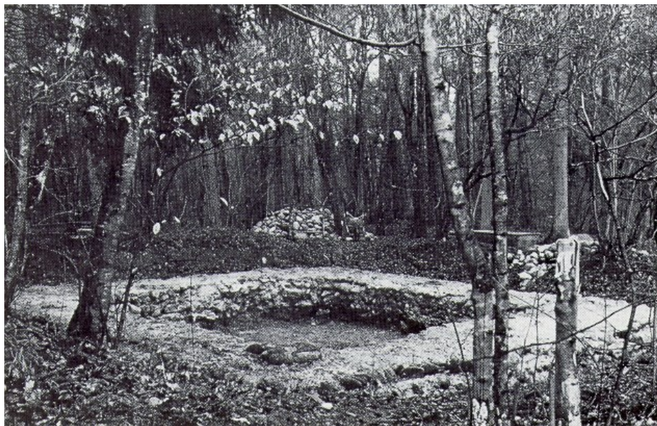
Abb. 4: Fundament der Römerwarte im Hard; während der Restaura- tionsarbeiten. Foto: Kantonales Hochbauamt, 1969
