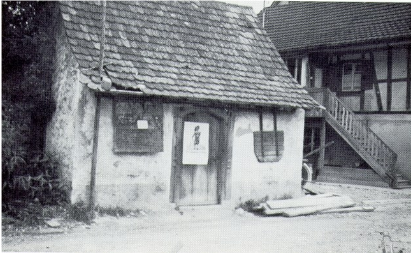
Abb. 16: Waschhaus untere Chälen (1962 abgebrochen)
